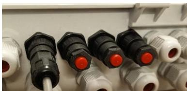
Figure 65 – Un seul appareil connecté, 3 bouchons
